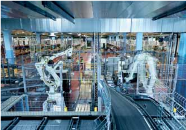
Депалетирование целых коробок раньше выполнялось вручную. Сегодня эту трудоемкую задачу берут на себя специальные роботы-депалетизаторы.
