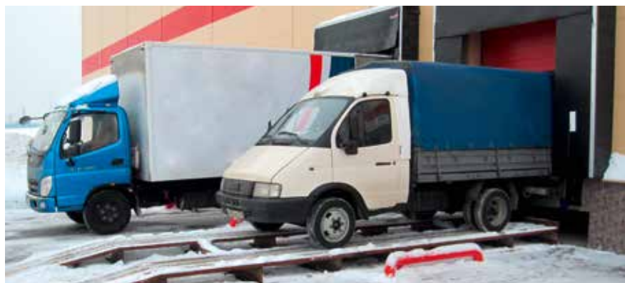
Рисунок 5. Эстакада для малотоннажных ТС Источник: фото автора
