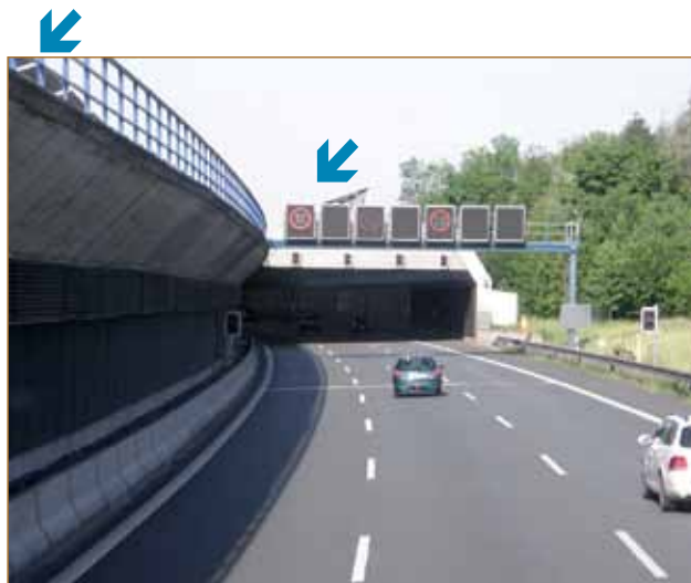
Расположенные на крыше тоннеля солнечные батареи (показаны стрелками) обеспечивают электропитанием освещение тоннеля, светофор, дорожные знаки, видеокамеру и колонну аварийной связи на трассе.
