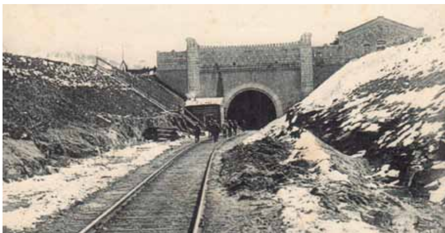
Рисунок 4. Хинганский тоннель (фото с сайта Транссибирская магистраль)
