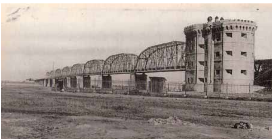
Рисунок 5. Мост через р. Сунгари близ ст. Харбин-Пристань, 7602 км, КВЖД (фото с сайта Транссибирская магистраль)
